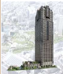
グラングリーン大阪 THE NORTH RESIDENCE
